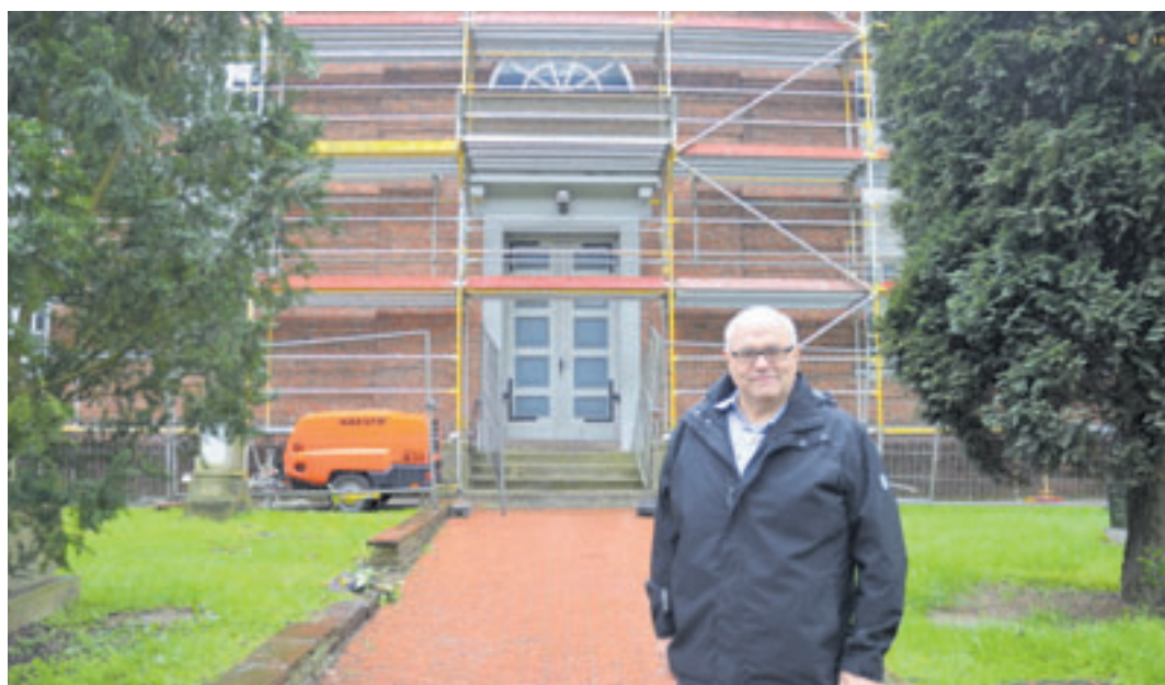
Der 1. Vorsitzende des Fördervereins Altenwerder, Bernd Meyer, ist mit den Fortschritten bei der Sanierung der St. Gertrudkirche sehr zufrieden Fotos: mk
