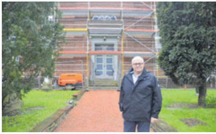
Der 1. Vorsitzende des Fördervereins Altenwerder, Bernd Meyer, ist mit den Fortschritten bei der Sanierung der St. Gertrudkirche sehr zufrieden.
