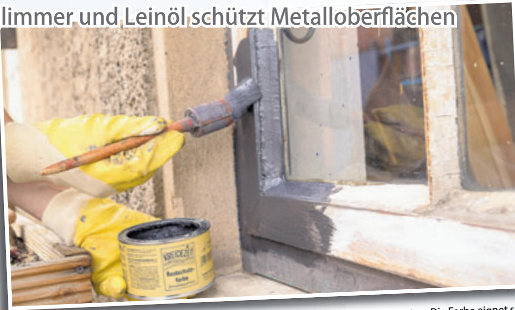
Es reicht, die Metallteile vor dem Anstrich per Drahtbürste oder Schleifpapier zu entrostern. Die Farbe eignet sich auch als dekorativer Anstrich für Holzoberflächen Foto: Kreidezeit Naturfarben
