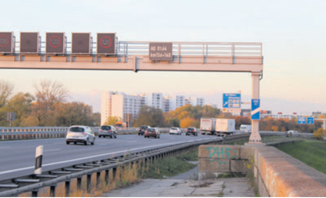
Die A1 auf Höhe von Kirchdorf-Süd: Die Hochhaussiedlung soll mit dem Ausbau einen vernünftigen Lärmschutz bekommen
