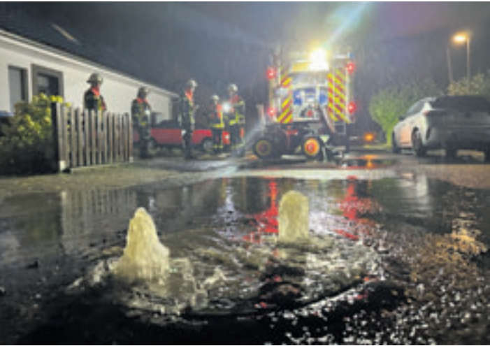
Am Heimstättenweg in Maschen lief die Kanalisation über und flutete einen Keller Foto: Tapken
