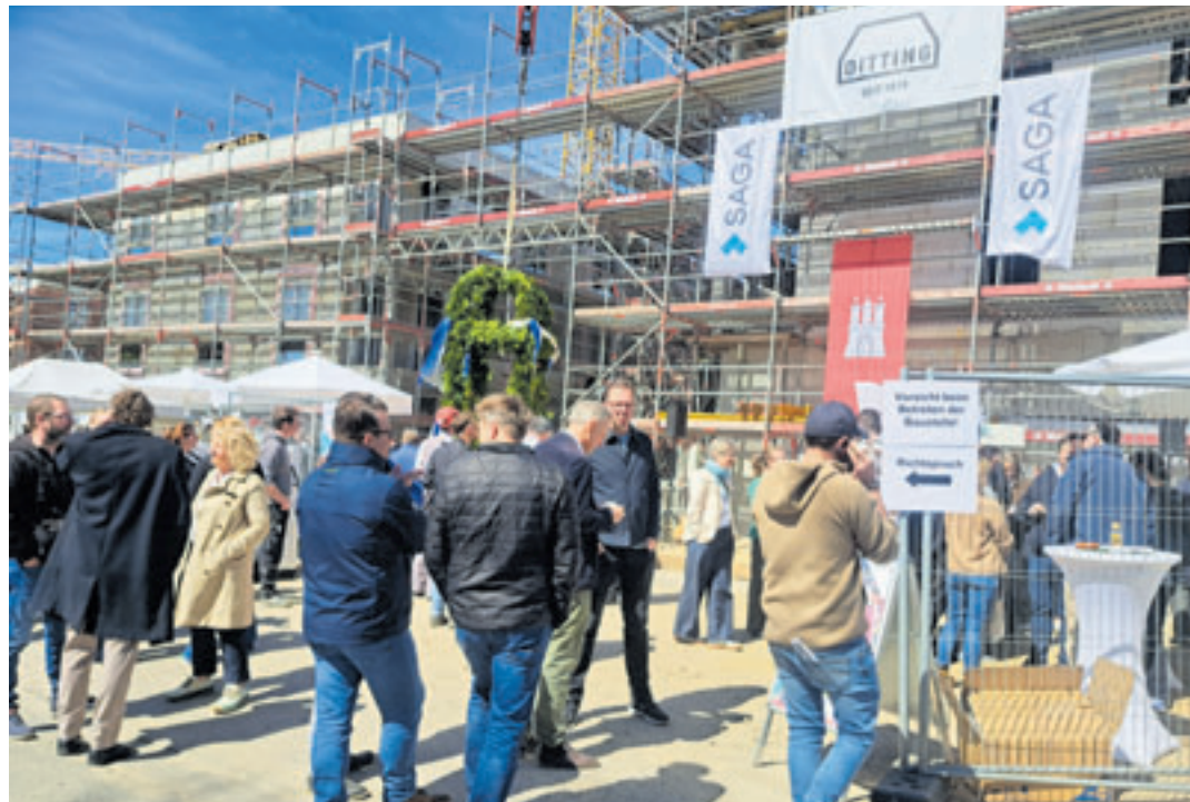
Noch sind die vier neuen Häuser am Lichtenauer Weg im Bau, aber 2027 sollen hier Menschen wohnen
