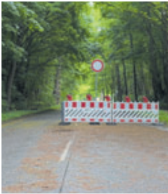
Von April bis August 2026 wurden unter anderem der Knotenpunkt Maldfeldstraße/Bremer Straße und die Einmündung Bremer Straße (Richtung Tötensen) erneuert Foto: mk
