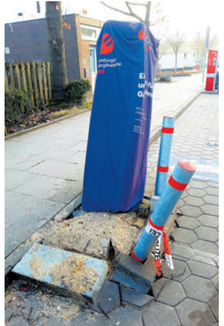
Wer ist für die Instandsetzung der zerstörten Ladesäule zuständig?
