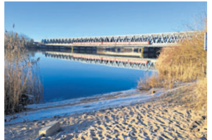
Mehr als 440 S-Bahnen bringen täglich die Menschen aus dem Süden über die Elbe und umgekehrt. Nun wird die Strecke für 14 Tage gesperrt Foto: sl
