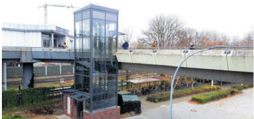
Häufig sind die Aufzüge am S-Bahnhof Neugraben defekt
