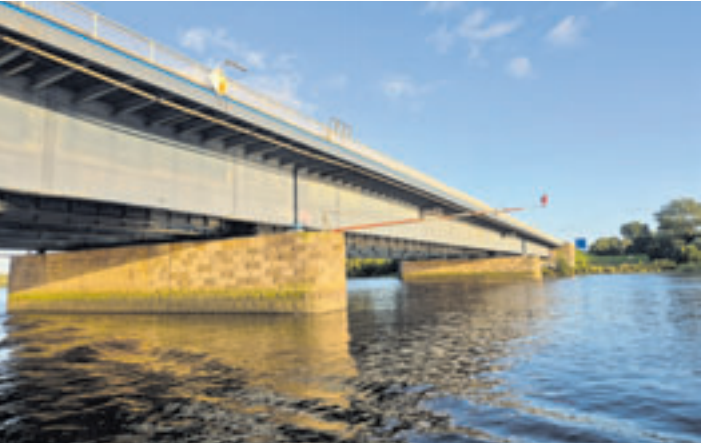
Die Süderelbbrücke muss erneuert werden. Derzeit finden zahlreiche vorbereitende Arbeiten statt Foto: au
