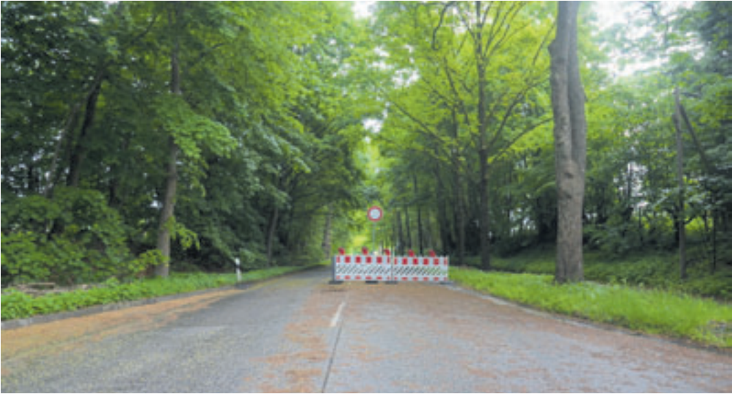
Von April bis August 2026 wurden unter anderem der Knotenpunkt Maldfeldstraße/Bremer Straße und die Einmündung Bremer Straße (Richtung Tötensen) erneuert Foto: mk
