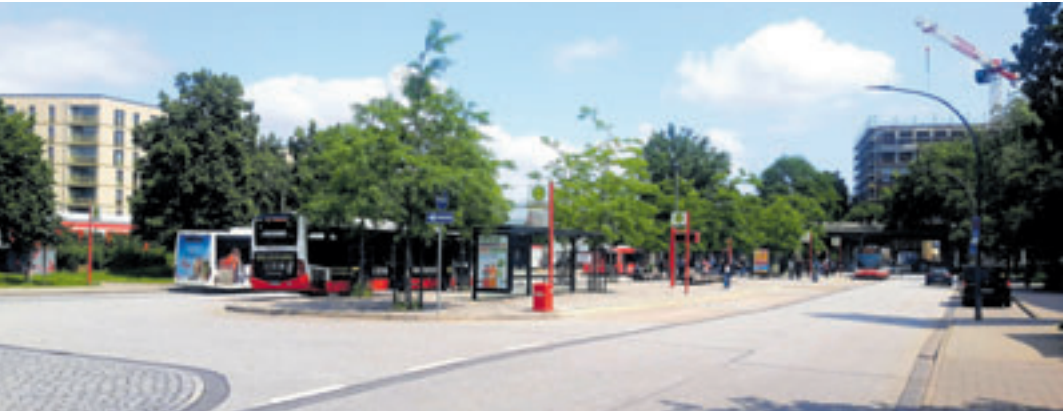
Laut SPD verzögern komplexe technische Planungen und die notwendige Errichtung eines Betonschalthauses den Bau eines Fahrstuhls am S-Bahnhof Neugraben zu den Gleisen 2 und 3
