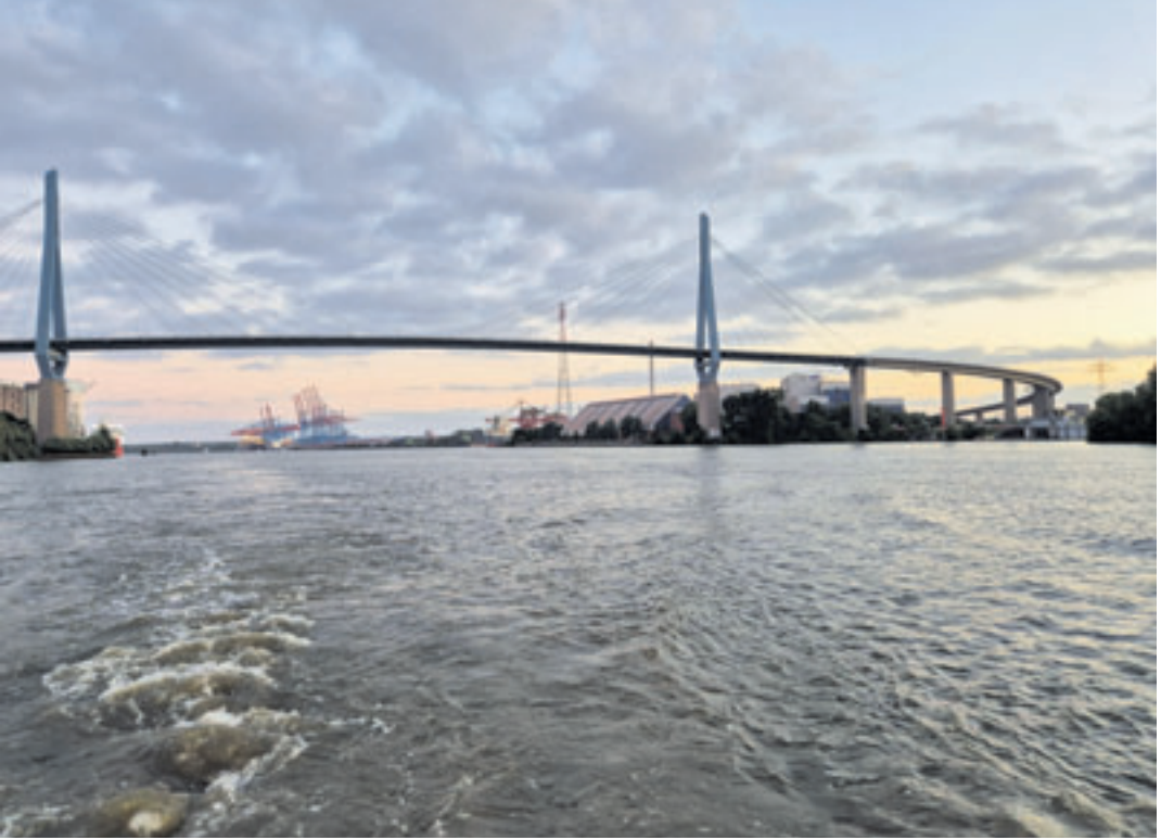
Die Köhlbrandbrücke: Ein Hamburger Wahrzeichen, das in die Jahre gekommen ist
