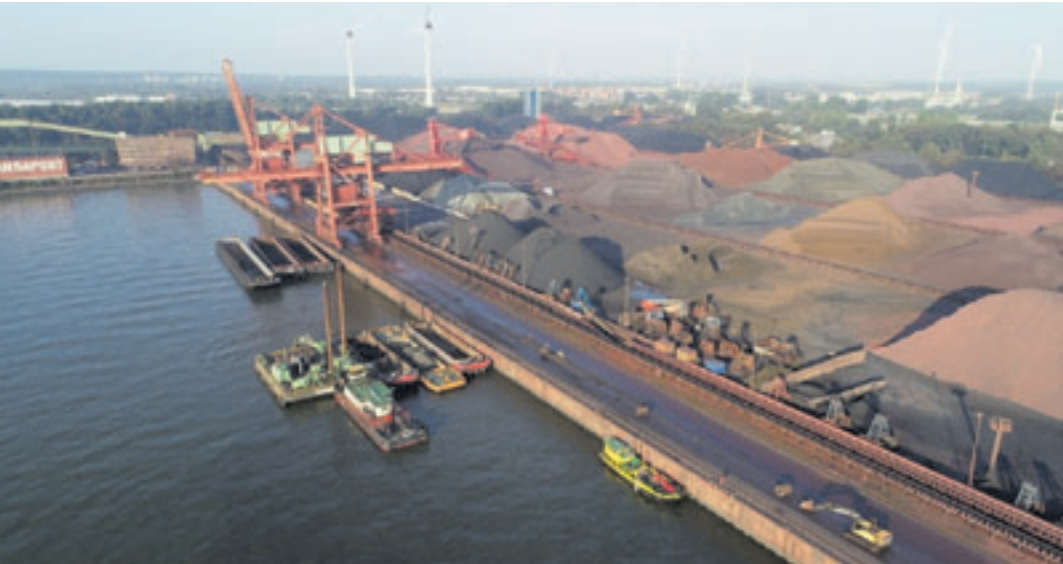
Der Salzgitterkai im Sandauhafen wird saniert
