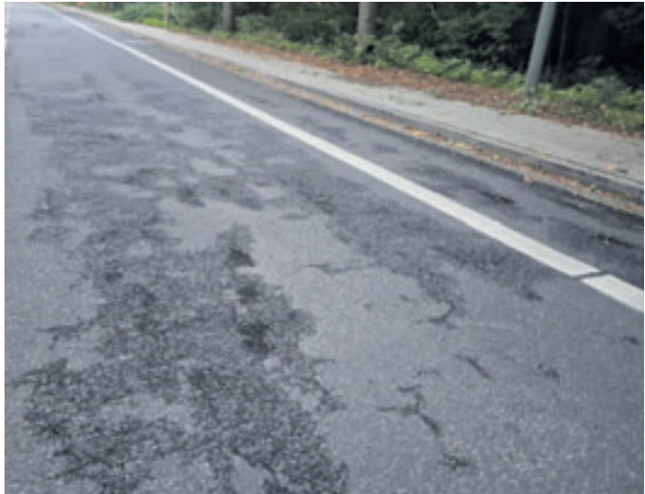
Eine Teilfläche auf der Georg-Wilhelm-Straße diente den Straßenbauern als Teststrecke für BioBitumen, der allerdings die Erwartungen nicht erfüllte Foto: au
