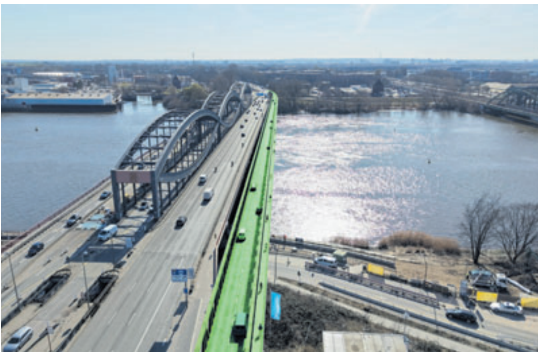
Die Behelfsbrücke wird westlich der Neuen Elbbrücken gebaut und verbindet den Oberhafenkanal, die Norderelbe und den Veddeleer Marktplatz. Sie erhält zwei Fahrstreifen sowie einen Rad- und Fußweg.
