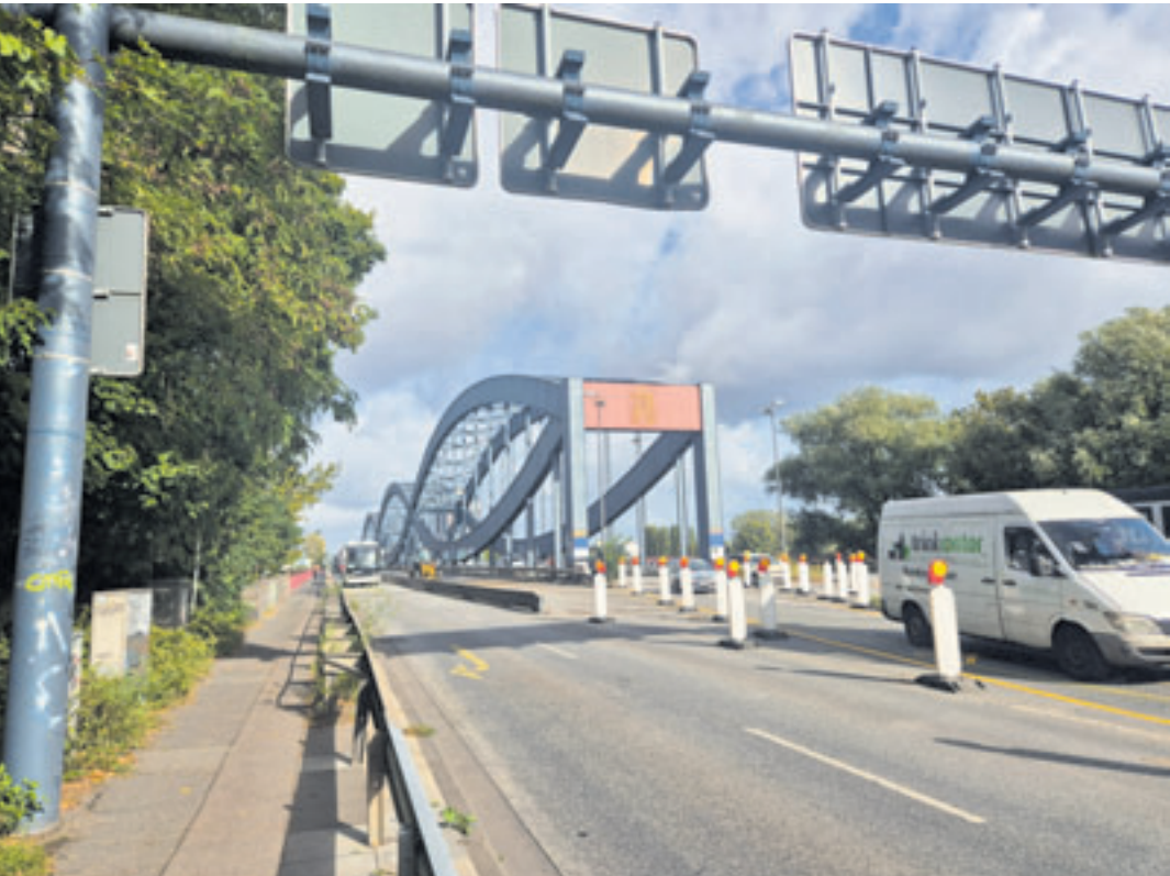
An den Neuen Elbbrücken wird seit Mai 2025 gearbeitet, nun wurde die letzte Bauphase eingeleitet Foto: au
